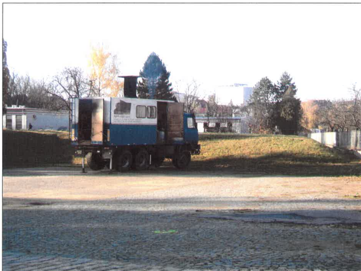
Foto č.3: Pohled na soupravu statické penetrace při realizaci sondy SP1A na budoucím staveništi kolejí pro VŠP v Jihlavě.
