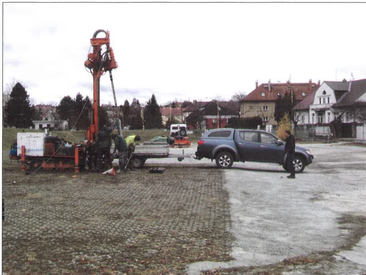
Foto č.2: Pohled na hloubení jádrového vrtu V6 vrtnou soupravou HVS 245 na budoucím staveništi kolejí pro Vysokou školu polytechnickou v Jihlavě.
