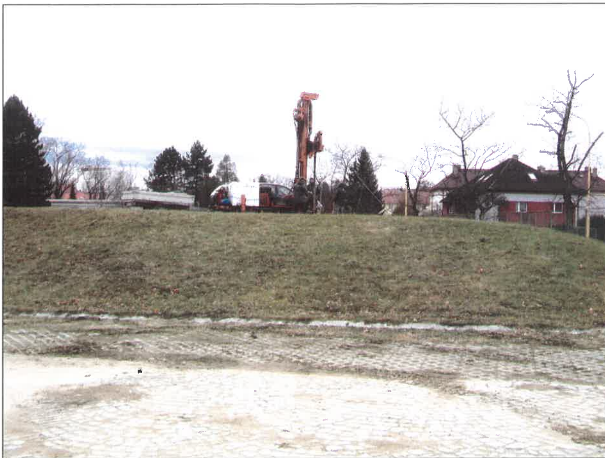
Foto č.4: Pohled na hloubení průzkumného vrtu V1 pro koleje VŠP v Jihlavě.
